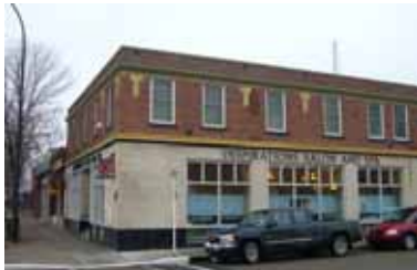
歴史的な建築物の保存・改修
