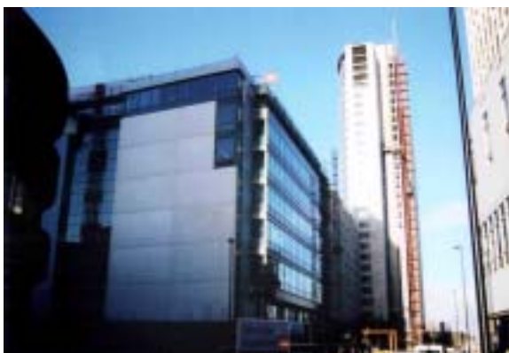
ビーサム・タワー（Beetham Tower）事業 / 左側：オールド・ホール通りから見る「オフィス棟、住宅棟」 / 右側：住宅棟（左） ホテル棟（中央） オフィス棟（右）
