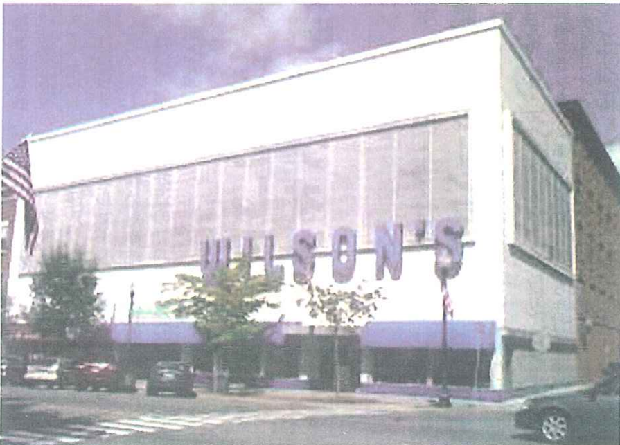
ウィルソン百貨店全景(1882年創業:正面側4階建て、後側5階建て)
