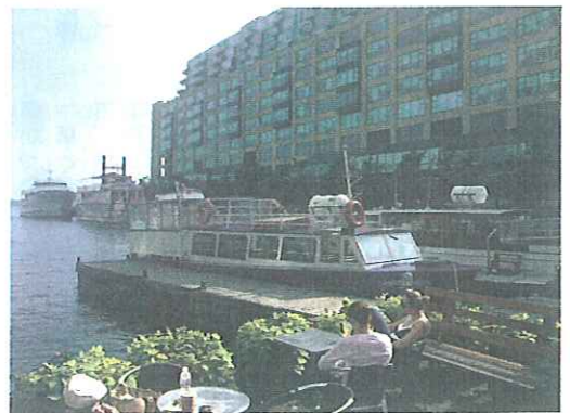
第1期事業の観光栈橋、商業・住宅施設整備
